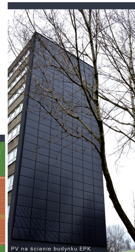
PV na ścianie budynku EPK
